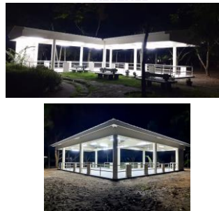
Construcción de zona de estudio ubicada en inmediaciones del Edificio de la Facultad de Ciencias Agrícolas de la Universidad de Córdoba Sede Montería
